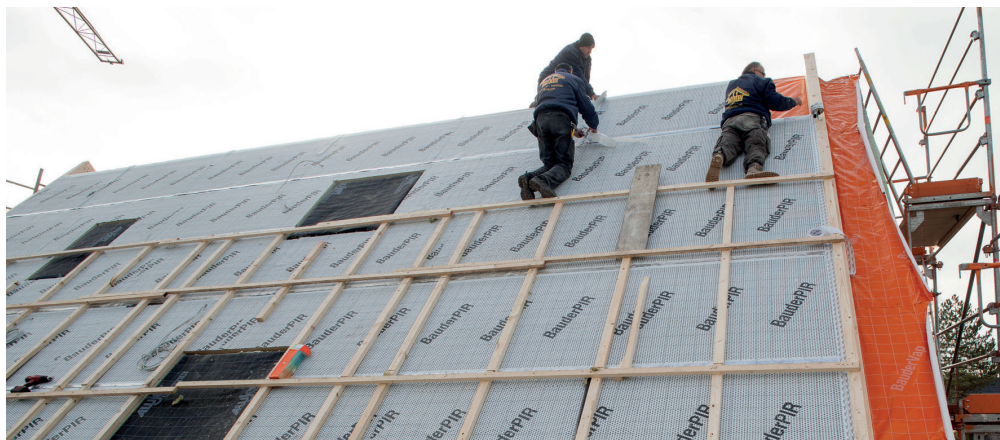
Energie sparen unterm Dach: Eine Aufsparrendämmung lohnt sich auch bei der Altbaumodernisierung. Foto: djd/Paul Bauder/Klaus-Reinold Klebe
